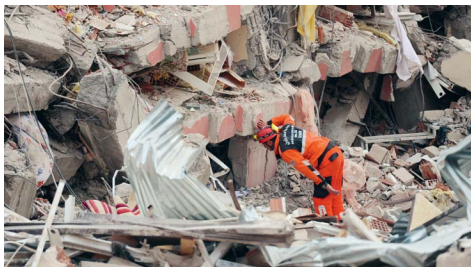
Рис. 66. Здание, разрушенное землетрясением
